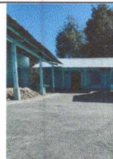
Foto 6: Sustitucion de piso de tierra por torta de concreto.
