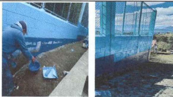
Foto 5: pintura en muros exterior e interiores.
